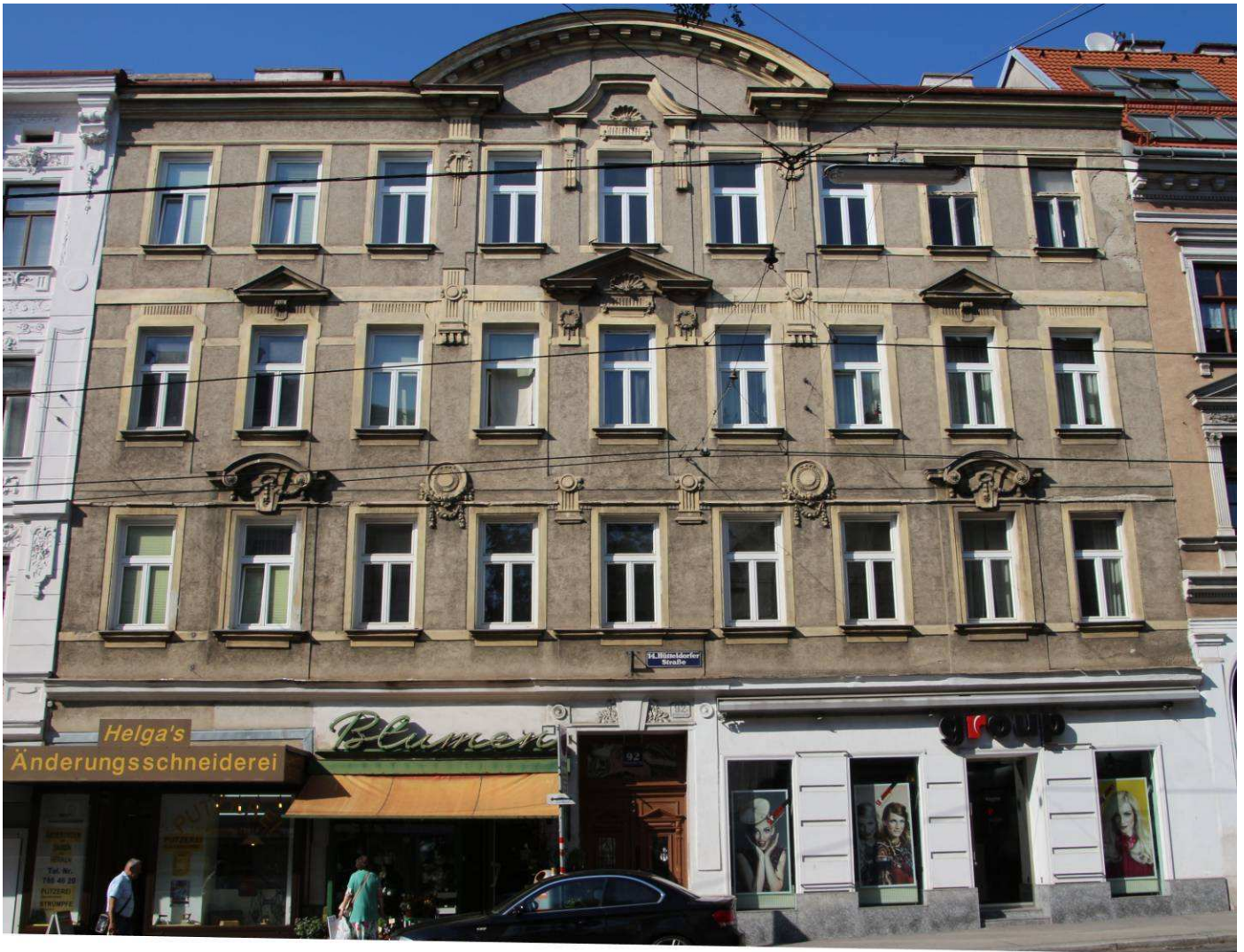
Das Haus in der Hütteldorfer Str. 92
