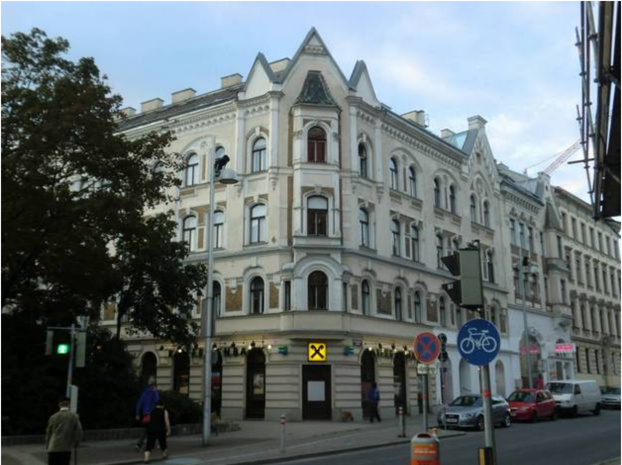
Das Haus in der Breitenseer Straße Ecke Kendlerstraße, vis a vis der Breitenseer Kirche.
